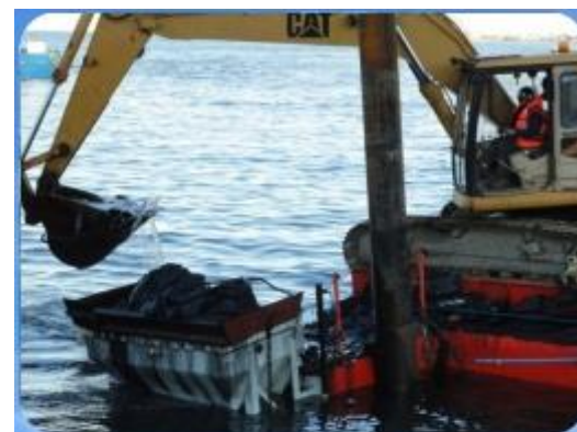
DRAGADO DE FONDO MARINO CALETA BARRANCO AMARILLO PUNTA ARENAS DIRECCION DE OBRAS PORTUARIAS.-PEY Y CIA LTDA.
