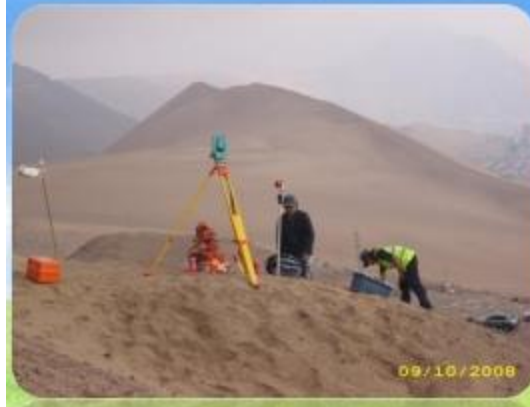
MEDICIONES DE GEODÉSIA Y TOPOGRAFÍA IQUIQUE PROYECTO TELEFÉRICO AGUNSA.
