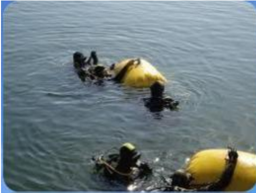
Trabajos de buceo con globos de levante
